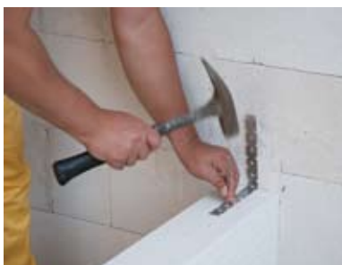
Starpsieni ar nesošo sienu savienojam, izmantojot metāla savienotājus.
