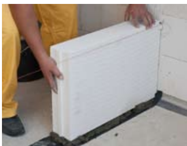
Pirmo bloku slāni veidojam uz tradicionālās javas, paturot prātā hidroizolāciju.
