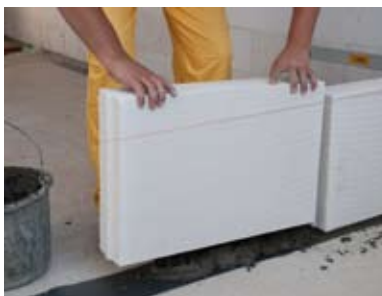
Pieliekam kārtējo bloku, neaizpildot vertikālās šuves, – tās aizstāj sistēma „spunde – grope”.
